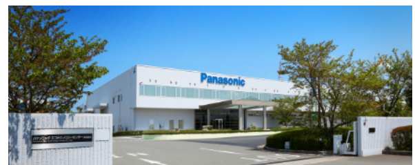
パナソニックエコテクノロジーセンター（兵庫県加東市） 出典：同社ウェブサイト
